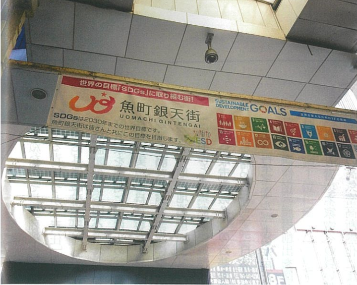
商店街内のLEDライトの電力はすべて、アーケードの屋根に設置されたソーラーパネルでまかなっている
